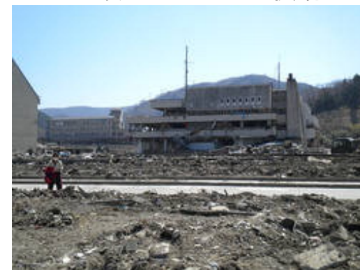
壊滅した女川町役場
